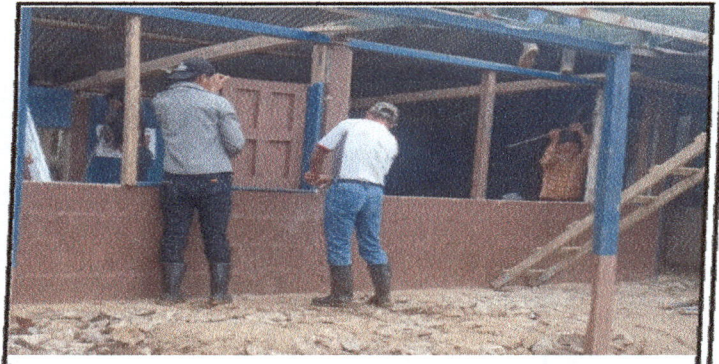
Foto 6: Remoción de la ventana de madera para cambiar con una ventana de metal y con vidrios.
