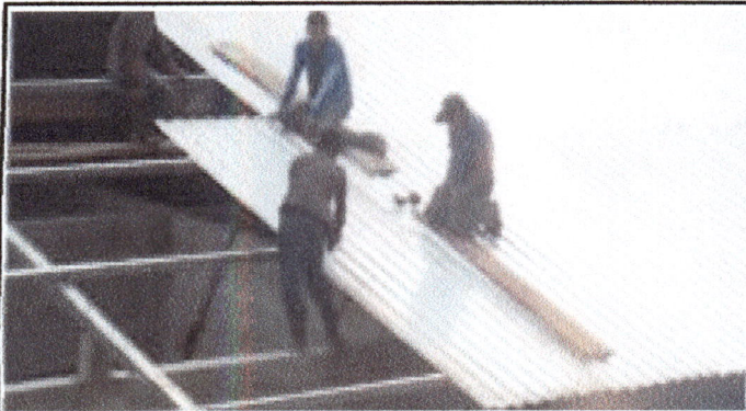
Foto 3: Sustitucion de cubierta de láminas para el modulo.
