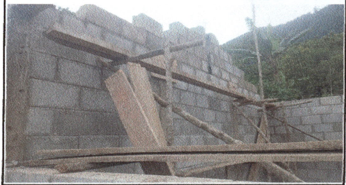
Foto 2: Colocacion de nuevas paredes de blocks en lugar de madera
